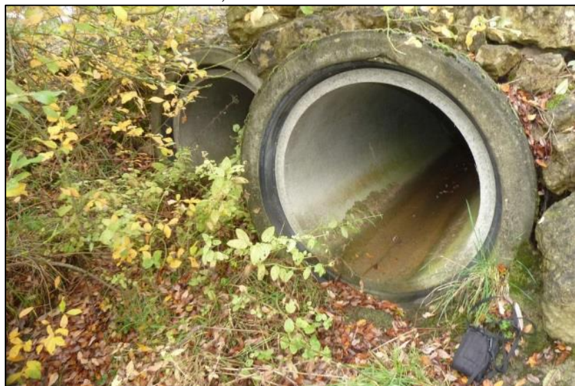
Déversoir, côté plan d'eau réaménagé
