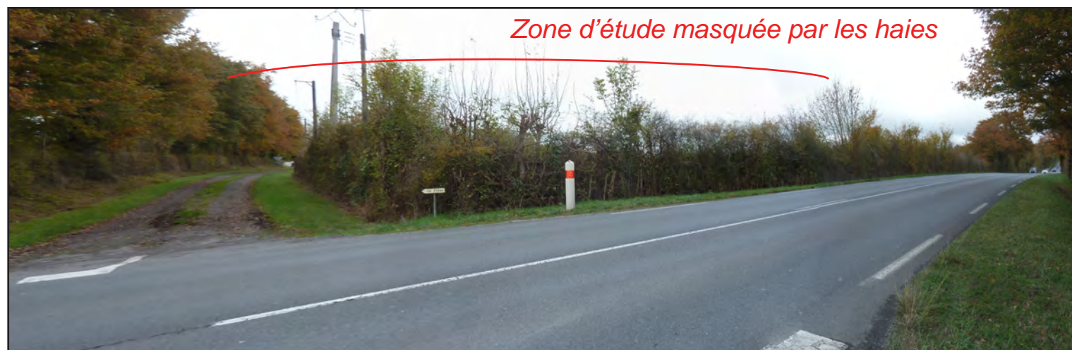
Point de vue G - depuis la RD938 (entrée du hameau le Frêne) - distance à la carrière : 710 m
