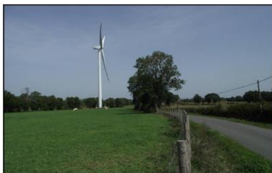
Parc éolien, Saint-Germain de Longue Chaume
