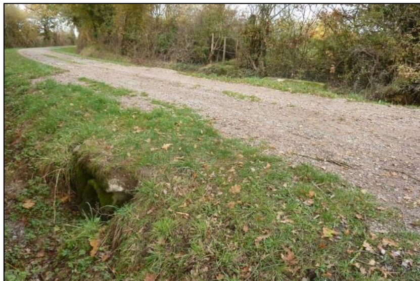
Déversoir, côté chemin des Marchands
