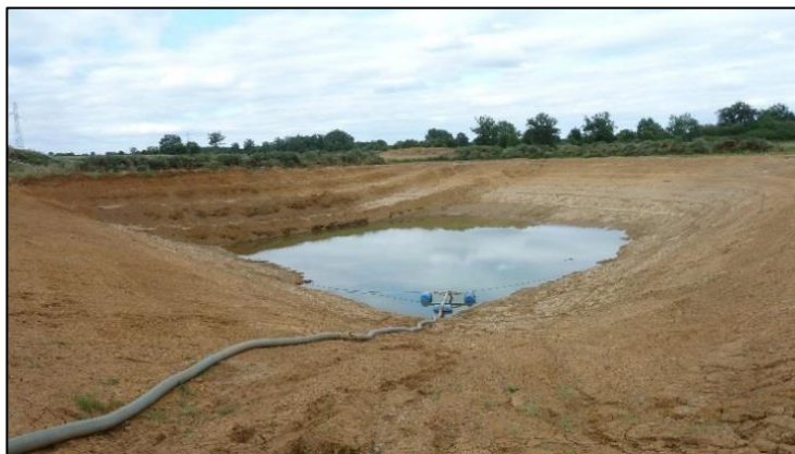
Photo 4 : Pompage des eaux superficielles accumulées dans l'excavation (gauche) et fossé dans lequel sont rejetées les eaux, en bordure sud du site (à droite)
